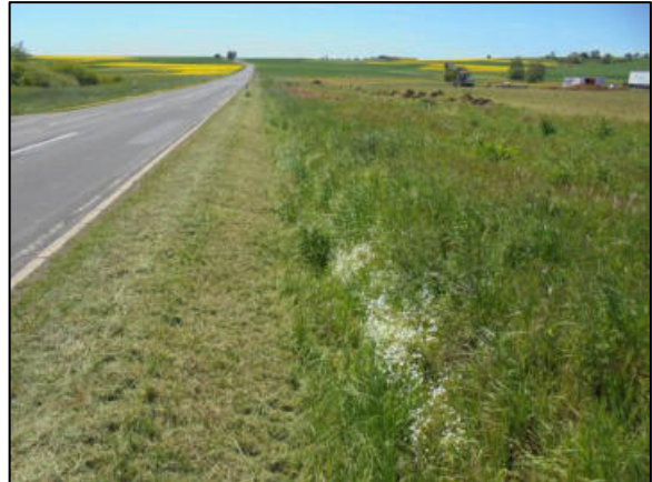
Foto 12: Verkrauteter, temporär wasserführender Graben westlich der Kreisstraße 166.
